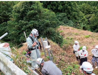
傾斜センサの設置風景
